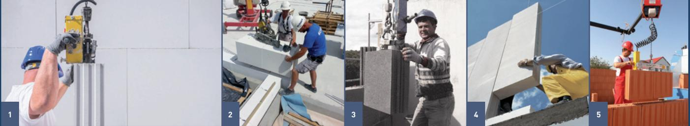
**Bildlegende:** 1 Kalksandstein, © E. Bayer Baustoffwerke/KS-PLUS, 2 Porenbeton, © H+H Deutschland GmbH 3 KLB-Quadro-Stein in Verarbeitung, © KLBQUADRO, 4 Porenbeton-Systemwandelemente, © Xella Deutschland GmbH Leichtbeton, 5 Ziegel, Poroton-T7, © Wienerberger GmbH
