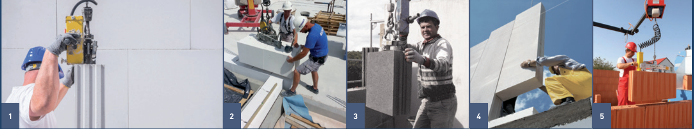
Bildlegende: 1 Kalksandstein, ©360° Design/Bundesverband Kalksandsteinindustrie, 2 Porenbeton, © H+H Deutschland GmbH 3 KLB-Quadro-Stein in Verarbeitung, © KLBQUADRO, 4 Porenbeton-Systemwandelemente, © Xella Deutschland GmbH Leichtbeton, 5 Ziegel, Poroton-T7, © Wienerberger GmbH
