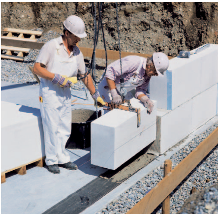
Abb. 6: Versetzen von großformatigen Planelementen aus Kalksandstein.
